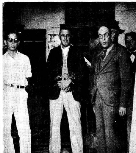
DESTRUIDA LA ESTACION RADIOTELEGRAFICA DE CAIBARIEN. —Los señores Oscar MADARIAGA, radiotelegrafista; Domingo MADARIAGA, dueño del edificio, y un inspector del Gobierno examinando los destrozos causados por la explosión de una bomba en la estación radiotelegráfica oficial de Caibarién. (Foto Martínez Illa)
